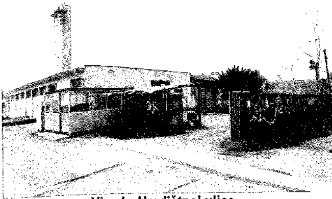
Vjazd z Hradištnej ulice
